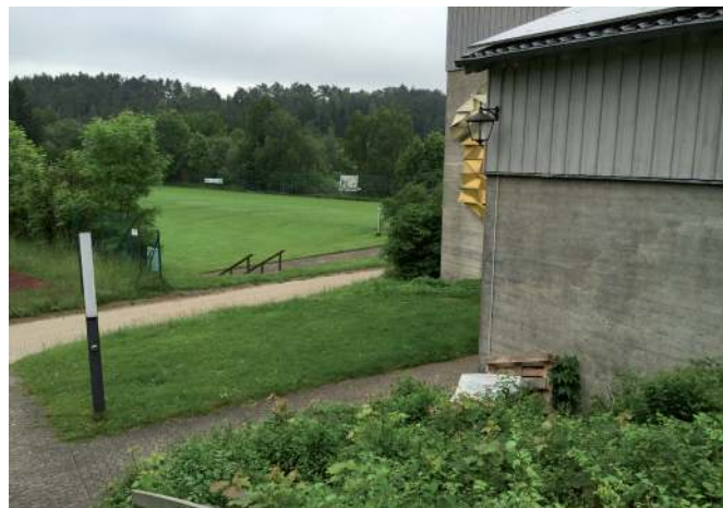
Außenbereich am geplanten Anbau
